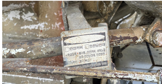
▲ M/T 안전난간대 설치 지원(낙상방지) ▼ M/T 안전슈트 설치 지원(끼임 방지)
