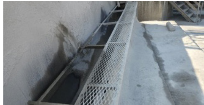
▲ M/T 발 헛디딤 사고 방지를 위한 안전발판 설치(우측면) ▼ M/T 발 헛디딤 사고 방지를 위한 안전발판 설치(좌측면)
