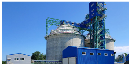
영동 1호기 화력 바이오매스 SILO 및 설비
